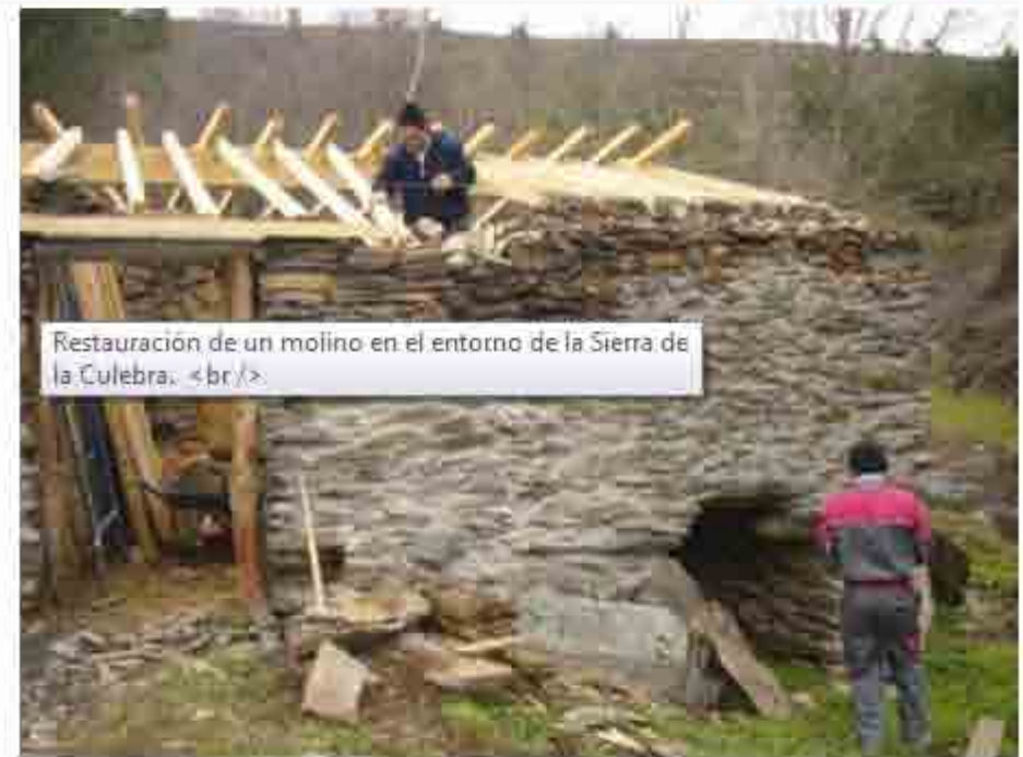
Restauración de un molino en el entorno de la Sierra de la Culebra. Foto L. O. Z.
