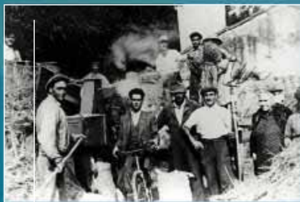
Malla con maquinaria nos anos 40 (na actual rúa do Repicho ?)
