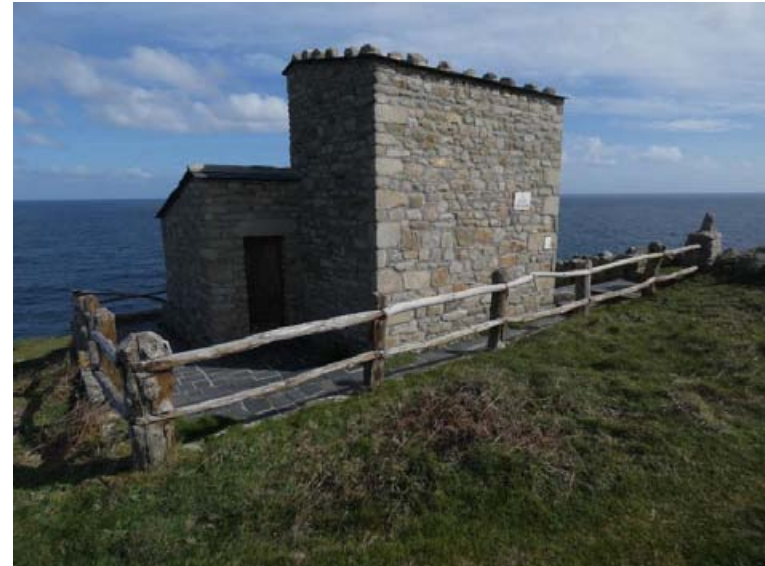
Imagen 39. Estación Ornitológica de Estaca de Bares
