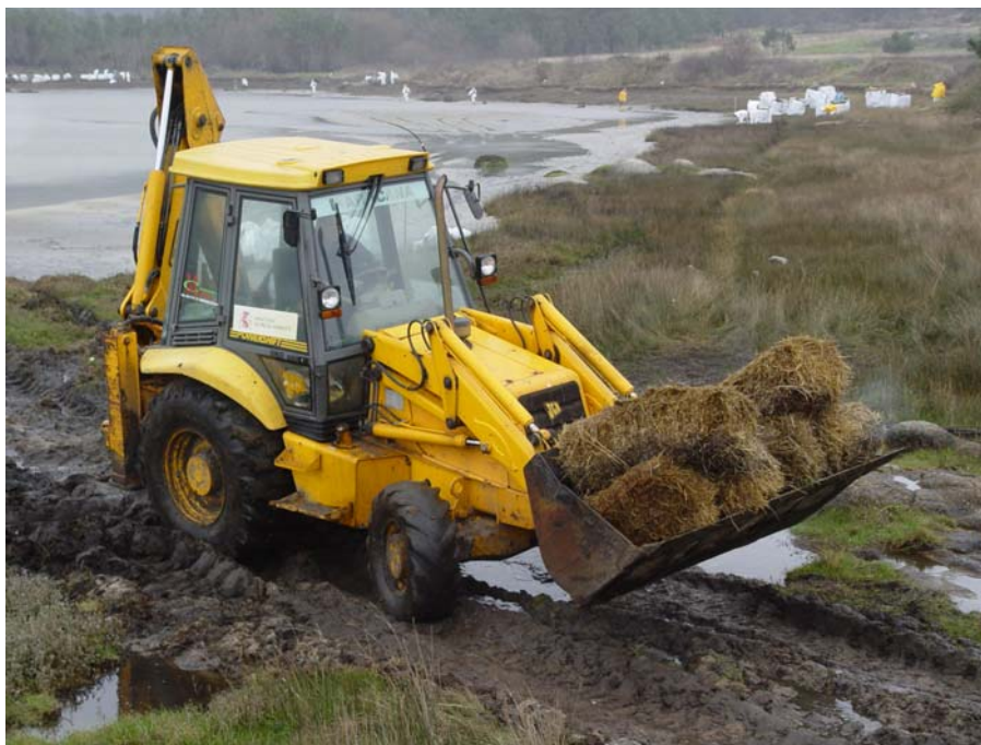
Ilustración 29. Maquinaria pesada traballando.
