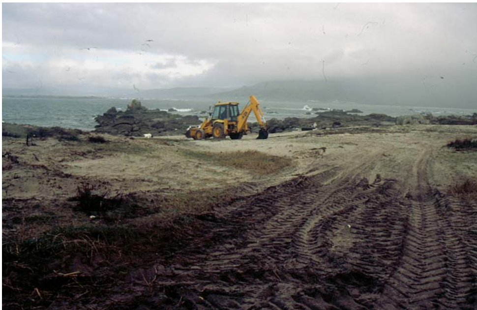
Ilustración 21. Introducción de maquinaria pesada e apertura de pista sobre dunas.
