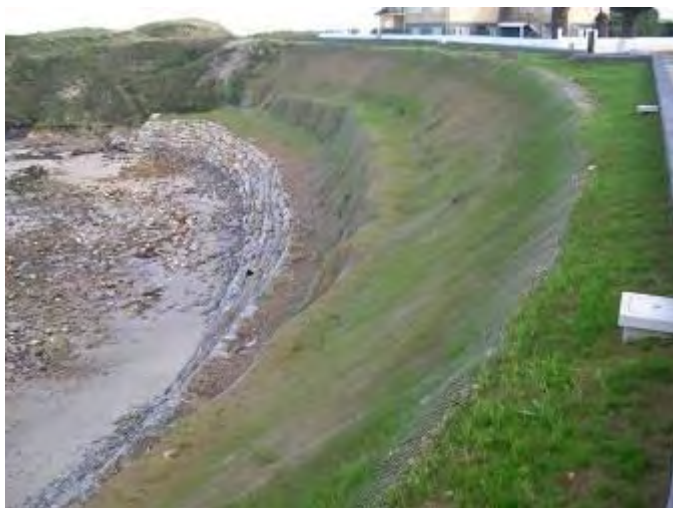
Estabilización do talude dun cantil na praia de Altar en Barreiros, Lugo (Setembro de 2006)
