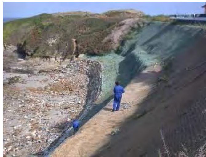
Estabilización do talude dun cantil na praia de Altar en Barreiros, Lugo (Setembro de 2006)
